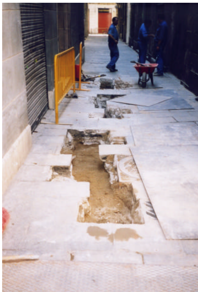
Foto 5. Vista general de la Rasa 3.
