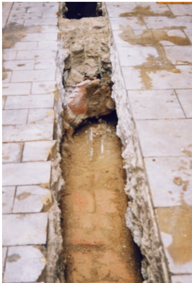
Foto3 . Detall de la claveguera (UE 104) apareguda a la Rasa 1.
