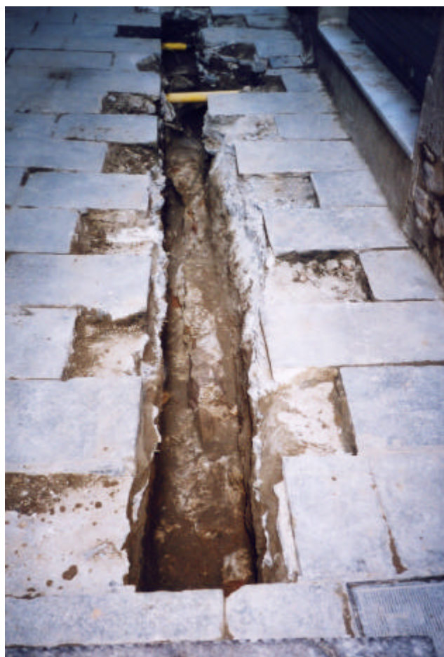
Foto 9. Rasa 4. Detall de l'estructura UE 404.
