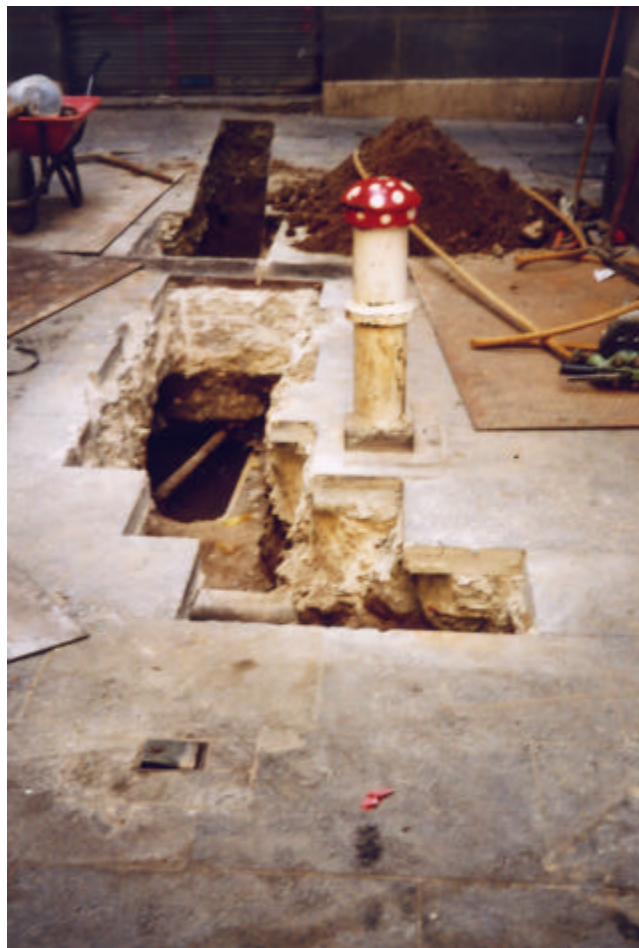
Foto 4. Vista general de la Rasa 2.
