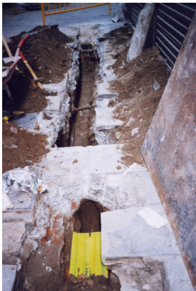
Foto 8. Detall d'un tram de la Rasa 4. A la fotografia s'observen la gran quantitat de serveis que es troben al subsòl.
