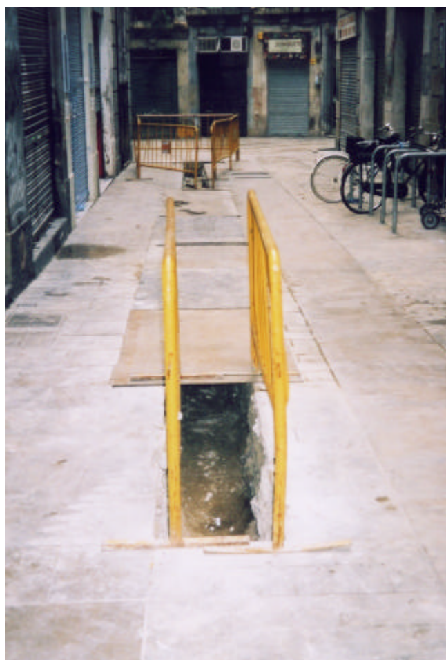
Foto 1. Estat de les obres en el moment d'iniciar el seguiment.
